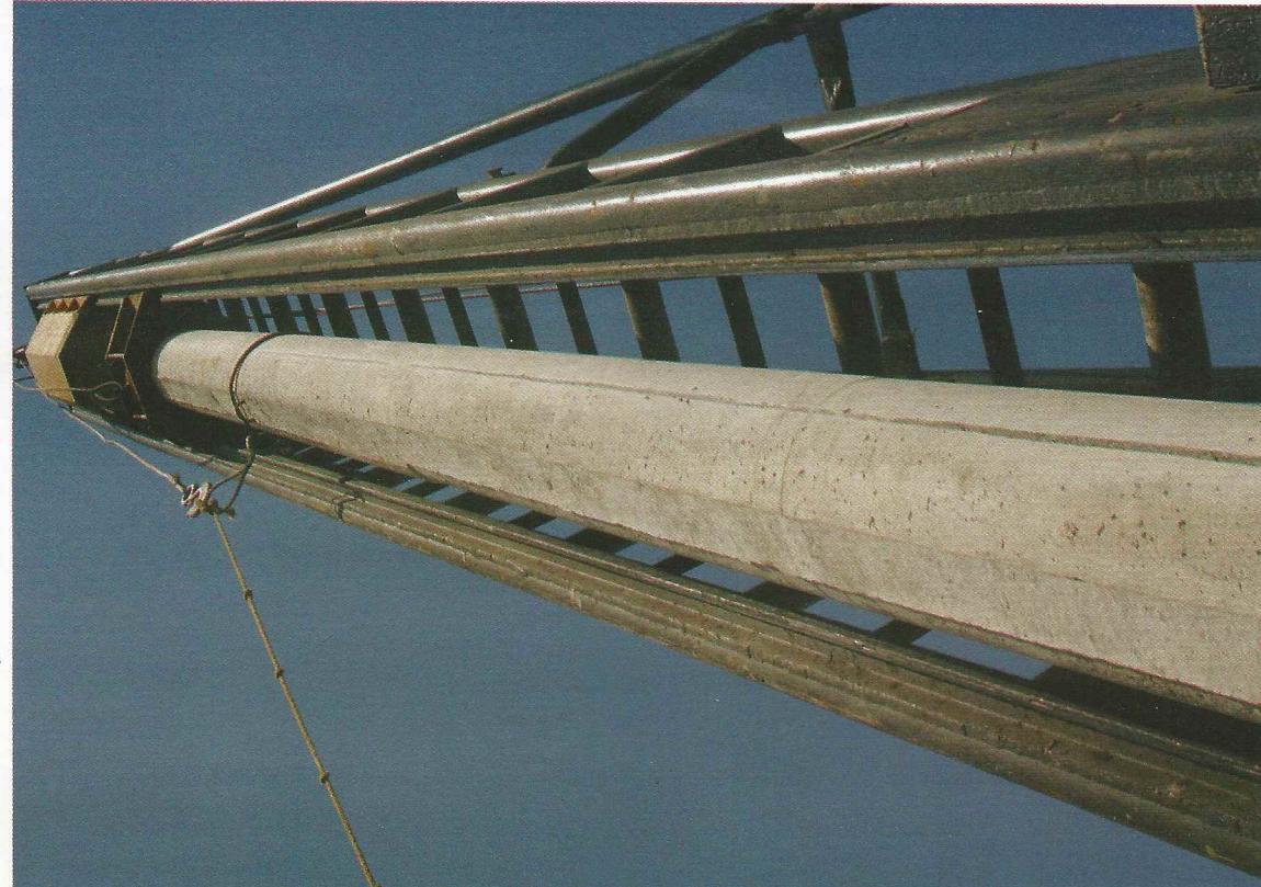
Com comprimento mínimo de 3 m, as estacas pré-moldadas podem ser de concreto armado ou protendido, vibrado ou centrifugado, com variadas formas geométricas
